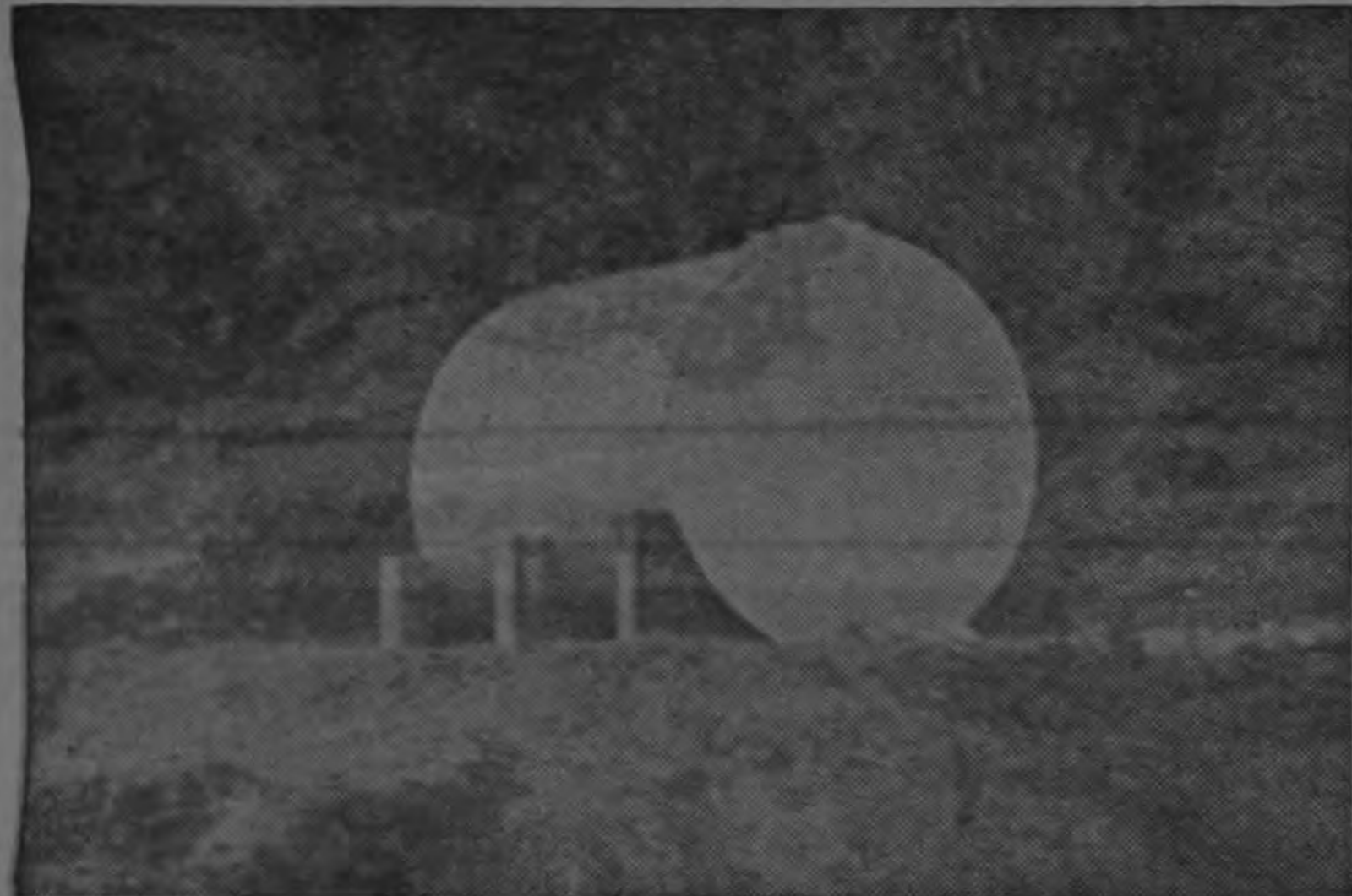
Tanque metálico de almacenamiento, colocado horizontalmente, del acueducto de Tempate de Santa Cruz. Este depósito de agua tiene 25.000 litros de capacidad.
